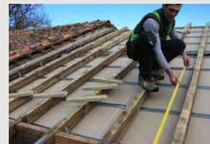
← Au préalable, retirer l'isolation thermique existante si l'épaisseur excède 10 cm ou si elle est en mauvais état.
