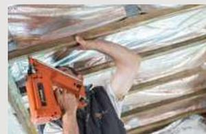
← Mettre en place sur les pannes les linteaux 60 x 40, pour réserver une lame d'air de 20 mm.
