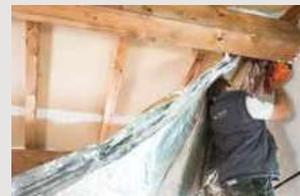
← **Agrafer la première couche du BOOST'R HYBRID<sup>®</sup> (face noire côté froid)** sur une extrémité puis le fixer en crémaillère entre chevrons avec l'accessoire ISOCLIP. L'ISOCLIP permet une fixation rapide par clouage, en assurant facilement la lame d'air lors de la pose en crémaillère et en utilisant judicieusement l'espace entre chevrons.
