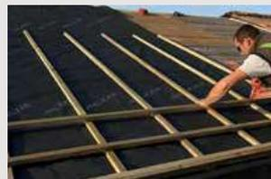
← Fixer des contre-liteaux de section 40x40 mm minimum au droit des chevrons puis fixer perpendiculairement des liteaux 20x27 mm avec un écartement compatible avec la couverture choisie.
