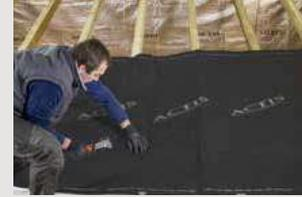
■ Dérouler à l'horizontale l'isolant **Boost'R Hybrid<sup>®</sup>**, languette débordante adhésive orientée vers le bas de pente, de la sablière et en prenant soin de le décaler d'au moins 30 cm par rapport au 1<sup>er</sup> lé d'isolant **Triso Hybrid<sup>®</sup>**.
