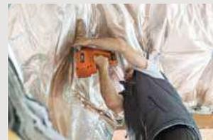
← **Une fois l'isolant Boost'R Hybrid<sup>®</sup> fixé côté mur**, continuer la fixation dans la longueur de la travée à l'aide de l'ISOCLIP vers le mur opposé.
