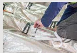
■ Aux jonctions des lés, les superposer et les fixer avec l'ISOCLIP au cloueur.
