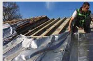
← Dérouler l'isolant Triso Hybrid<sup>®</sup> horizontalement sur les chevrons en prenant soin d'orienter la languette adhésive en direction de la sablière et l'agrafer en respectant les règles essentielles de mise en œuvre. Commencer la pose en partant de la sablière et en remontant jusqu'au faîtage.
