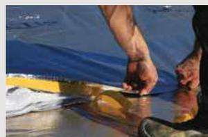
← **Poser horizontalement le deuxième lé** en respectant la continuité de l'isolant et de l'étanchéité à l'eau et à l'air. Agrafer les lés tous les 5 cm sur les entretoises préalablement installées et assurer la jonction horizontale des lés à l'aide de la languette adhésive de recouvrement du TRISO HYBRID<sup>+</sup>. Respecter la continuité de l'isolant au faîtage.
