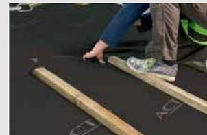
← **Reproduire les opérations précédentes** en assurant la continuité de l'isolation et de l'étanchéité à l'eau et à l'air jusqu'au faitage.
