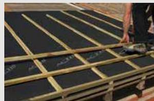
← **Fixer des contre-liteaux** de section 40x40 mm minimum au droit de la seconde rangée de contre-liteaux puis fixer perpendiculairement des liteaux 20x27 mm avec un écartement compatible avec la couverture choisie.
