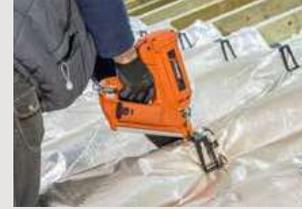
■ Poser l'isolant **Triso Hybrid<sup>®</sup>** horizontalement, languette débordante adhésive orientée vers le bas de pente. Commencer la pose en partant de la sablière et en remontant jusqu'au faitage.
