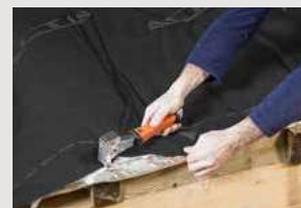
■ En périphérie de l'isolation, réaliser un retour d'isolant de 50 mm au minimum sur lui-même.
