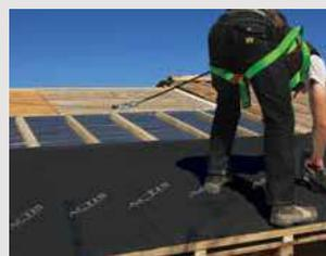
← **Dérouler à l'horizontale l'isolant BOOST'R HYBRID<sup>+</sup>** en partant de la sablière. Agrafer BOOST'R HYBRID<sup>+</sup> tous les 30 cm sur les contre-liteaux et réaliser la jonction verticale des lés au droit d'un chevron en respectant la continuité de l'isolant et en garantissant l'étanchéité avec l'aide du MULTIDHESIF.
