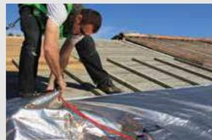
← **Dérouler l'isolant TRISO HYBRID<sup>+</sup>** horizontalement sur l'ossature bois réalisée en prenant soin d'orienter la languette adhésive en direction de la sablière et l'agrafer en respectant les règles essentielles de mise en œuvre. Commencer la pose en partant de la sablière et en remontant jusqu'au faîtage.
