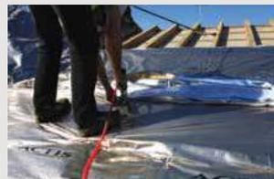
← Poser horizontalement le deuxième lé avec un recouvrement de 5 cm minimum sur le 1<sup>er</sup> lé pour la reprise en longueur. Agrafer les lés tous les 5 cm sur les entretoises préalablement installées et adhésiver la jonction à l'aide de la languette de recouvrement du Triso Hybrid<sup>®</sup>.
