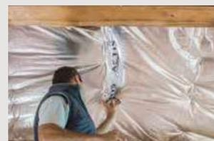
■ Fixer ensuite l'isolant **Triso Hybrid<sup>®</sup>** sur les contre-linteaux, toujours en partant d'un mur vers le mur opposé, de linteau en linteau, avec une pose tendue pour assurer la lame d'air non ventilée de 20 mm entre le **Boost'R Hybrid<sup>®</sup>** et le **Triso Hybrid<sup>®</sup>**.
