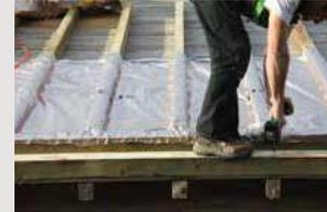
■ **Dérouler horizontalement le TRISO HYBRID<sup>®</sup>** avec la languette débordante adhésive orientée vers le bas de pente. Commencer la pose en partant de la sablière vers le faîtage.
