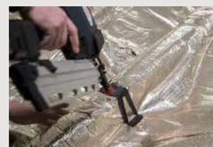
← En couverture, réserver un espace ventilé de 20 mm au minimum entre la face inférieure du liteau de support de couverture et Boost'R Hybrid<sup>®</sup> (en respect des DTU série 40).
