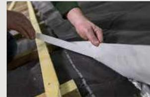
■ Poser horizontalement le **deuxième lé d'isolant Boost'R Hybrid<sup>®</sup>** avec un recouvrement de 10 cm minimum sur le premier lé.
