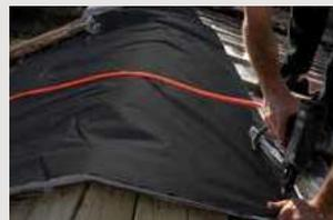
← Poser horizontalement le deuxième lé d'isolant Boost'R Hybrid<sup>®</sup> en réalisant la jonction des lés grâce à la languette débordante adhésive intégrée, de manière à garantir la continuité de l'isolation et de l'étanchéité. Bien maroufler.
